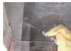
A.WJS工法でのアスベスト除去の様子
